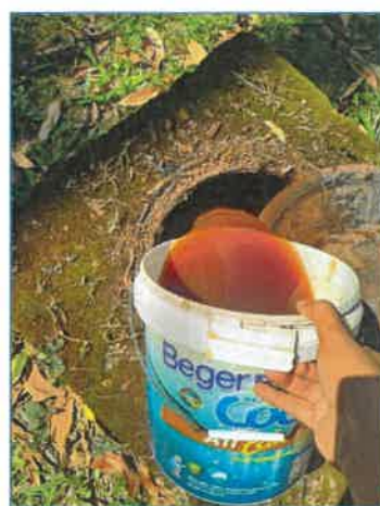
ภาพถ่ายที่ 2.2-1 ตำแหน่งระบบบำบัดน้ำเสียของแต่ละอาคาร การเติมหัวเชื้อชีวภาพในถังบำบัด
